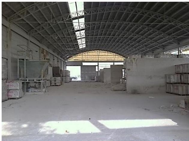
Il corpo **D** è costituito da una tettoia con struttura portante in ferro e copertura a falde con capriate metalliche e lamiera grecata per il deposito dei prodotti finiti. Si tratta di quattro campate che presentano chiusura esterna a mezz'altezza con blocchetti di cemento lapillo, collegate ai capannoni (A) mediante una pensilina con la stessa tipologia costruttiva. Il piano è parzialmente soppalcato per aumentare la superficie di deposito.
