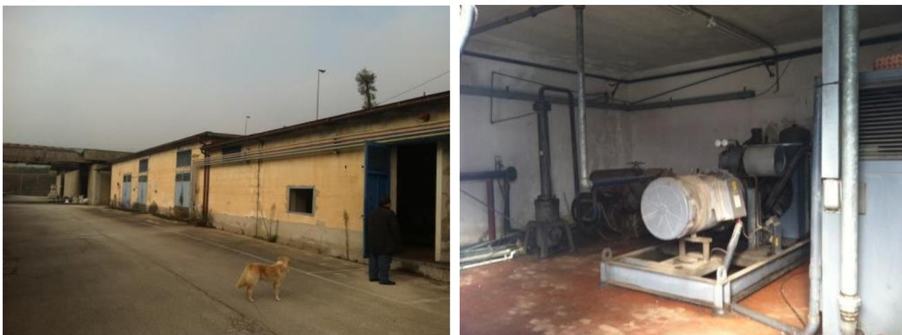
L'alloggio del custode (**F**) presenta struttura portante prefabbricata, tamponature prefabbricate, copertura a falde inclinate, infissi esterni in alluminio e interni in legno, pavimentazioni e rivestimenti in ceramica ed è dotato di impianto idrico-fognario, elettrico e telefonico.
